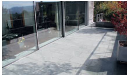
Natursteine mit Fugenkreuzen, offen belassen
