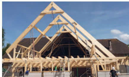
Aufrichten der Binderkonstruktion und Balkenlage
