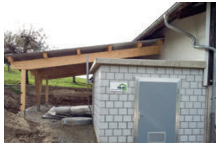
Technikraum und Gaslager vor der Fertigstellung
