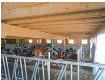
Stall mit Unterzug für Balkenlage Heuraum
