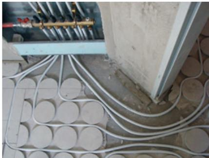
*Therm 25: Die Platten der Therm 25 bieten zusätzlich einen guten Trittschallschutz.*
