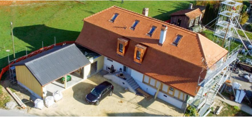
sprüngliche Dach vom Stöckli über den neuen Gebäudeteil verlängert werden. Vier neue Dachgauben ermöglichen die Belichtung der Räume in der Gebäude-mitte. Zusätzliche Dachfenster bringen Licht in den hohen Bereich des neu sichtbaren Dachraums. Die neuen Dachrandabschlüsse wurden der früheren Situation entsprechend nachgebildet.
