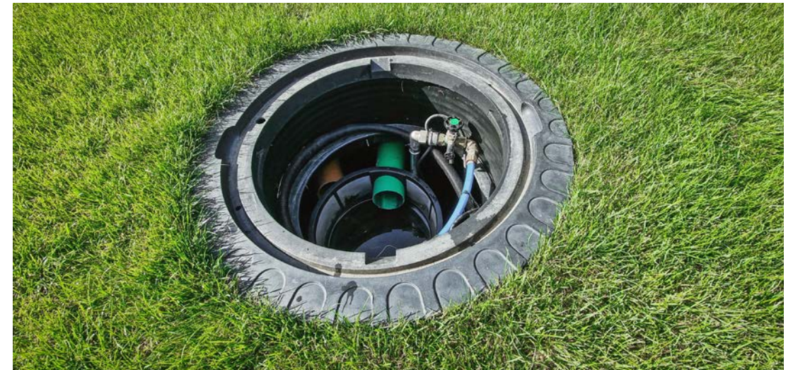
▲ In der Erde verbauter und verschliessbarer Regenwassertank
