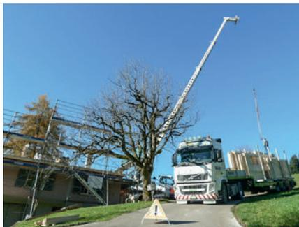
Die Elemente wurden auf der Baustelle mit unserem Teleskopstapler versetzt. Die wettergeschützte Zeit der Wohnung im EG betrug ab Abbruch der bestehenden Konstruktion bis zur neuen Dachkonstruktion ca. 1 Woche.
