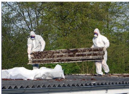
Rückbau von asbesthaltigen Wellplatten
