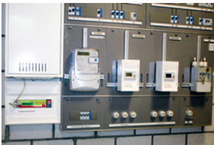
Eingebauter SmartFox mit Privatzählern.
