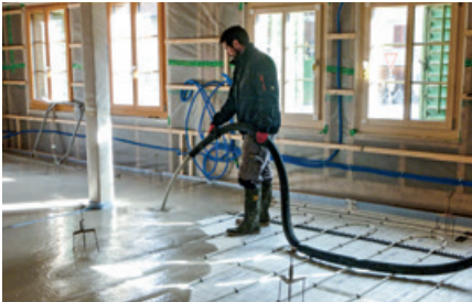
Eingiessen des Fliessestrich.
