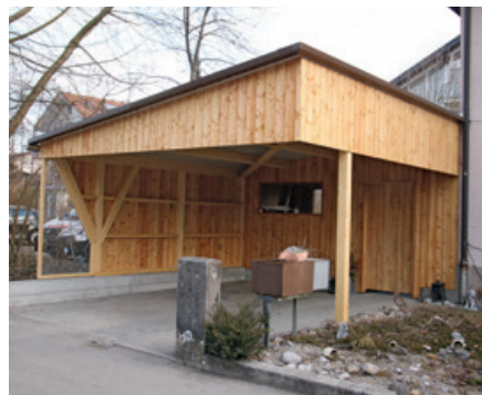
Fertig erstellter Unterstand.
