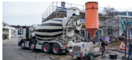
Pumpeinsatz mit eigener Fliessmörtelpumpe.
