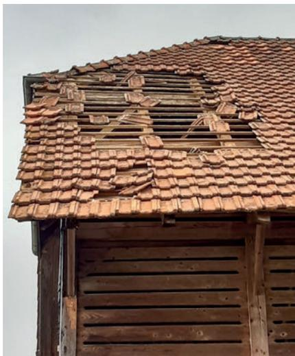
Manchmal jedoch, wenn die Dachfläche kaum einsehbar ist und keine defekten Ziegelreste auf der Hauseinfahrt liegen, bleiben die Schäden unentdeckt. Dies hat zur Folge, dass die Beschädigung an der Unterkonstruktion durch die Witterungseinflüsse grösser wird und weitere negativen Auswirkungen hat.
