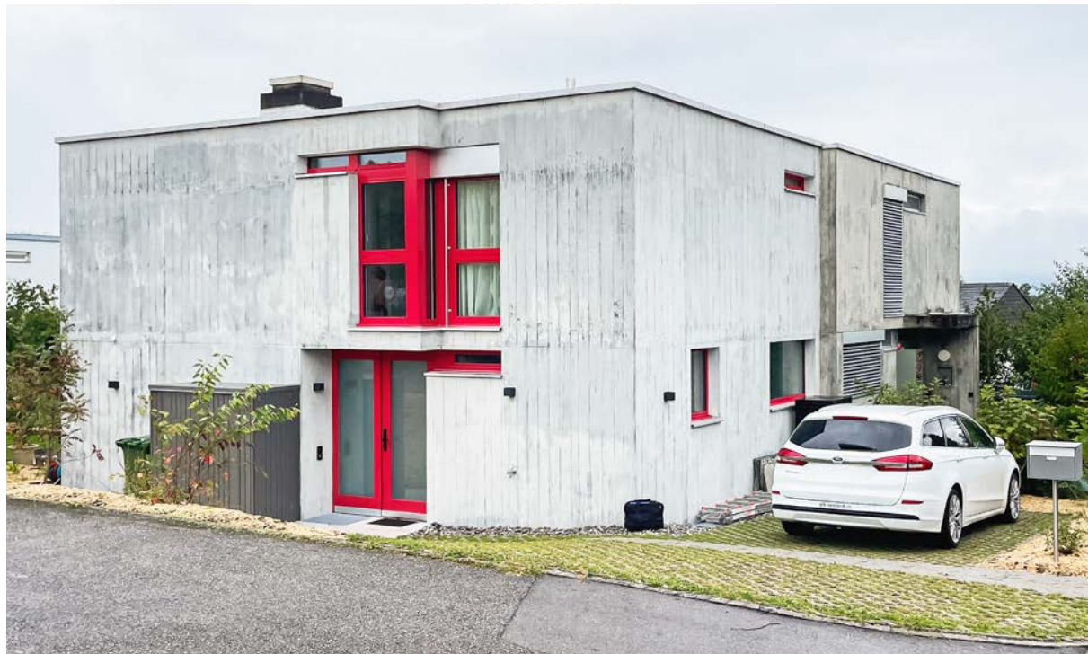
▲ Bild nach der Sanierung
