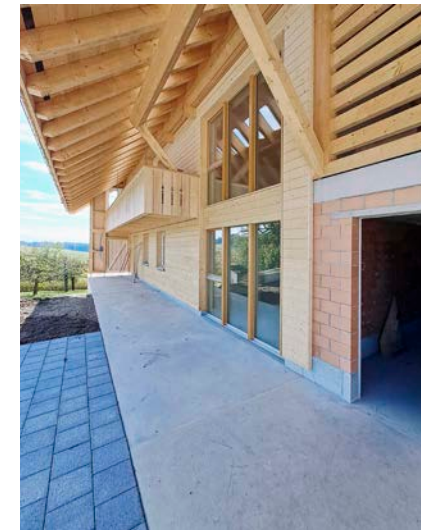
◀◀ Sichtbacksteinfassade im Ökonomieteil ▲ Offenes Kalksteinmauerwerk
