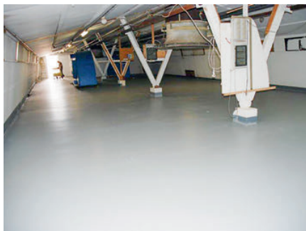
Fertiger Raum vor der Installation
