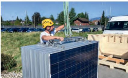
Sämtliche Bauteile sind bereits vormontiert und können einfach mit dem Kran auf das Dach gehoben werden. Auf dem Dach müssen diese nur noch miteinander verbunden werden. Dadurch verringern wir nicht nur die Montagezeiten, sondern
