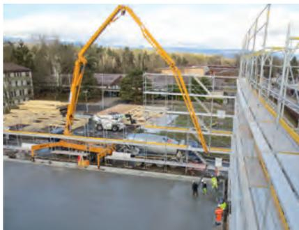
*Betonieren der Bodenplatte zwischen die Streifenfundamente.*
