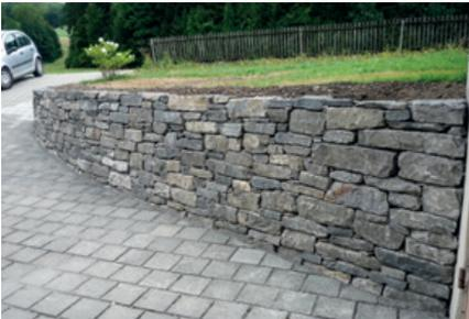
Diese Art von Stützmauer wirkt mit dem Eigengewicht gegen den Hangdruck. Das bedeutet, je grösser der Höhenunterschied ist, umso massiver muss die Mauer erstellt werden und umso grössere Steine sind zu verwenden. In der Regel werden die Mauerwerke trocken verlegt, das heisst ohne Mörtel oder Kleber aufeinander geschichtet. Auch ist ein Anzug (leicht schräg zum Erdreich) einzuplanen.
