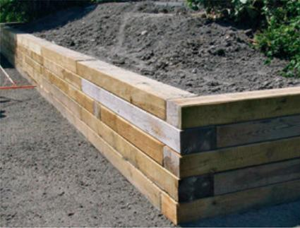
Sehr verbreitet sind heute noch Bahnschwellen. In öffentlichen Anlagen dürfen diese nicht mehr verwendet werden. Alternativ bieten wir heute druckimprägniertes Holz an. Ebenfalls kann mit unbehandeltem Hartholz nach wie vor ein Holzstützwerk gebaut werden. Die Holzschwellen werden vor Ort versetzt und rückverankert je nach Bauhöhe. Im Vergleich zum Naturstein oder Beton ist diese Konstruktion weniger langlebig.
