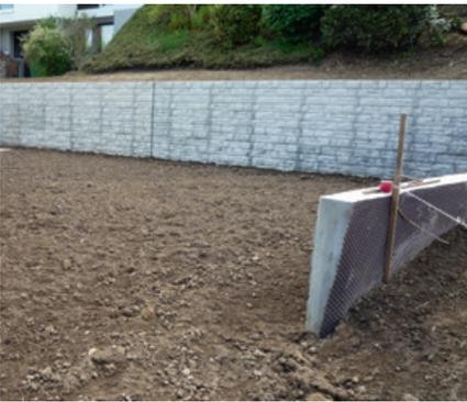
*Betonmauer mit Struktureinlage.*
