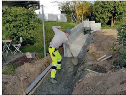
Winkelplatten werden als Fertigprodukt geliefert und vor Ort versetzt. Optisch kommen sie der Betonstützmauer sehr nahe. Die Besonderheit ist die schnelle Bauweise. Der Bauhöhe sind aber Grenzen gesetzt. Die Winkelplatten sind Betongrau und in den Höhen 0,50 m bis 3,00 m erhältlich. Ebenfalls zu beachten ist, dass je grösser die Bauhöhe ist, desto stärker das Versetzgerät (Bagger oder Lastwagenkran) sein muss.
