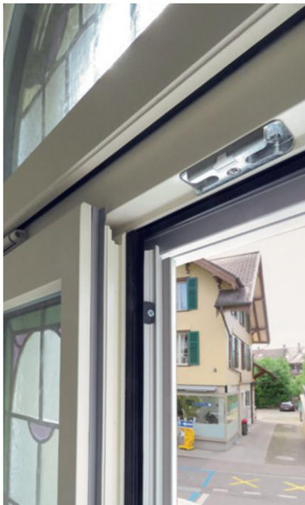
*Moderne Verriegelung, doppelte Gummidichtung.*
