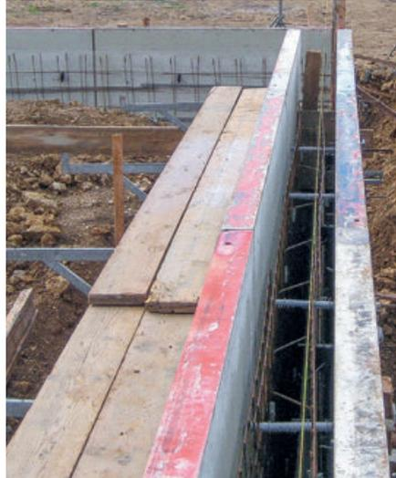
*Altes, herkömmliches Betoniergerüst (im Aufbau).*
