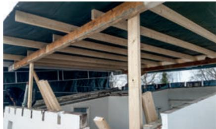
*Notdach während der Bauarbeiten.*
