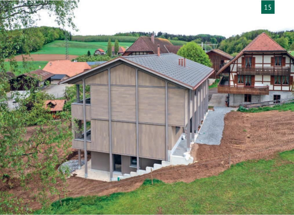
Die Fassadengestaltung mit zahlreichen Details aus stehender und liegender Holzschalung, ausgeführt mit Schweizer Tannenholz, reagiert auf die vorhandenen prägenden Elemente der Bestandsbauten mit Sockel, Zwischengeschoss und Dach. Zudem erhält die Thematik der Lauben und Stützen ein Gewicht in der Ausgestaltung der Fassade.
