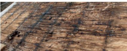
*Alte Dachkonstruktion beim Abbruch (starke Fäulnis).*
