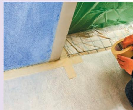
3. Weiter geht's mit dem Abkleben der Kanten. Verwenden Sie dafür **Malerklebeband**. Achten Sie darauf, dass die Kanten genau abgeklebt sind, um Farbkleben zu vermeiden. Extratipp: Ziehen Sie nach dem Abkleben mit einem **Spachtel** die Kanten des Klebebands mit wenig Druck nach, um dieses richtig zu befestigen.
