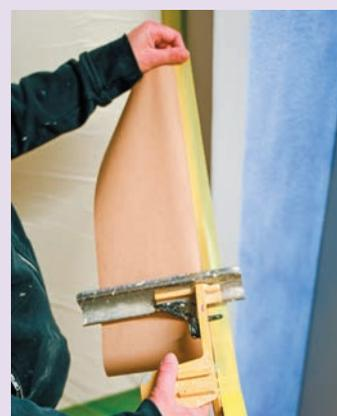
4. Nun können Sie Flächen wie Küchenablagen, Möbel, Fenster sowie Türen abdecken. Verwenden Sie bei Möbeln eine **3M-Folie** (ohne Klebebandrand), bei Fenstern und Türen ist eine **Abdeckfolie mit integriertem Klebeband** praktisch.
