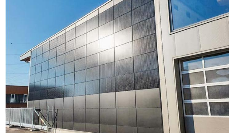
► gebäudeintegrierte PV-Anlage bei der GLB Seeland von 3S Swiss Solar Solutions AG
