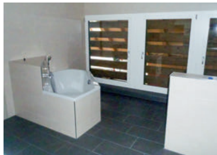
Einbau von Badezimmern.
