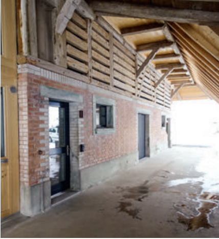
Sanierung und Erhalt der Fassade im Ökonomiebereich. Ergänzung und Anpassung des bestehenden Mauerwerkes.
