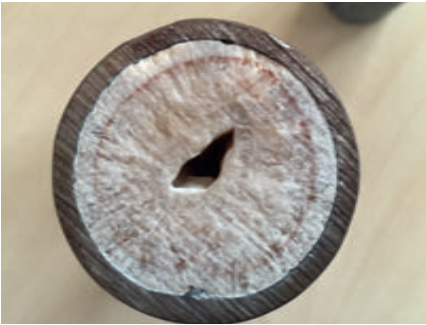
Leitungsschnitte Spinsstrasse 6, Aarberg, WW-Leitung.
