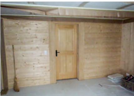
Innenausbau im bestehenden Wohnteil. Innen- und Aussenwände mit breitem Täufer ausführen. Einbau von gestemmten Innentüren.
