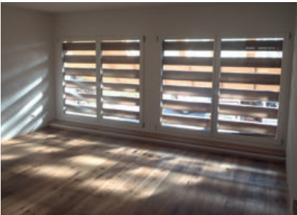
Sanierung und Erhalt der Gymwand.
