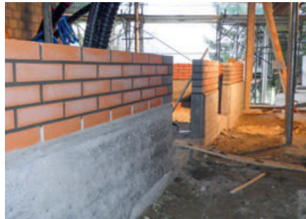
Sichtmauerwerk unter Hocheinfahrt. Mauerwerk wurde demjenigen des Ökonomiebereiches angepasst.
