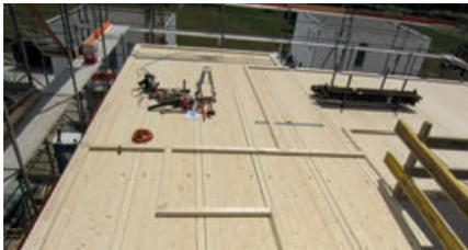
Beim Dachstuhl der Familie Gerster sind die sichtbaren Sparren im Innenbereich statisch bloss für das Eigengewicht und die Dachschalung gerechnet. Die Über sparren, welche nur im Vordachbereich sichtbar sind, übernehmen die Aufgabe der Statik des Daches. Die Detaillösung des Anschlusses an die Pfette ermöglicht ein rasches Aufrichten. Die Pfette wirkt sehr schlank, da der sichtbare Sparren mit einer Schwalbenschwanzverbindung an der Vorderseite gehalten ist.
