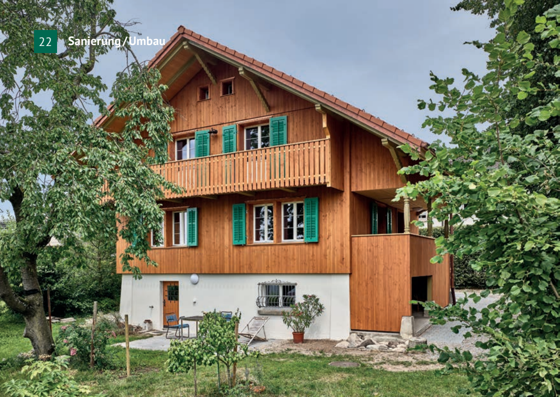
Südseite des Hauses
