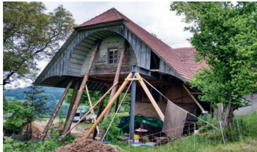
14 Mehr Platz dank einem neuen Dachstuhl
