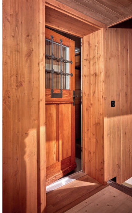
Eingangstüre, die äussere Schicht wurde erhalten und auf die neue Türe aufgesetzt.
