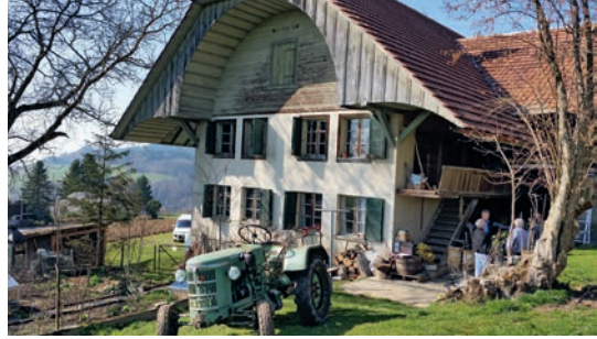
Keller, EG und OG werden abgerissen, Dachkonstruktion bleibt erhalten.
