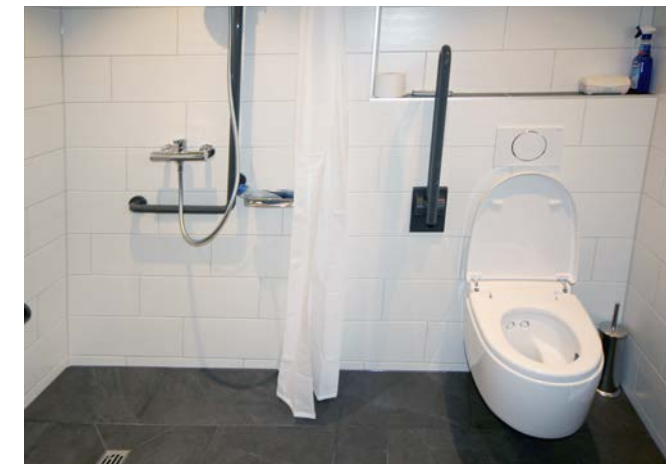
▲ Das Bad nach der Sanierung.
