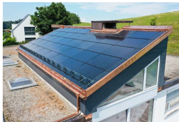
▲ Indach-Photovoltaikanlage
