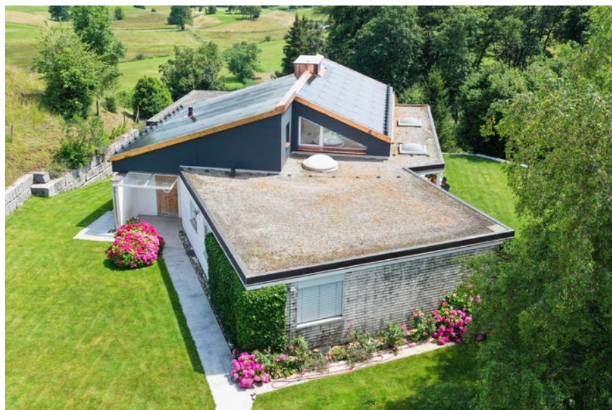
▲ Indach-Photovoltaikanlage
